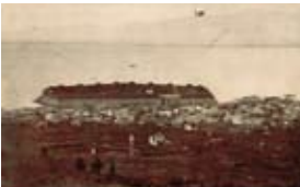
箱館奉行支配諸術調所教授役武田斐三郎が設計した台場跡。新島襄が箱館に来る目的の一つは、武田斐三郎のもとで学ぶことであった。※写真提供/函館市中央図書館
