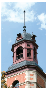
黒色の鉄板が取り付けられた塔屋部分
