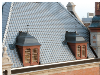
復原されたドーマー窓(上)と工事風景(左)
