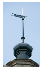
復原された風見(左)と大棟尖塔飾り(下)。下写真中央の煙突雨除けも竣工時に復原されました
